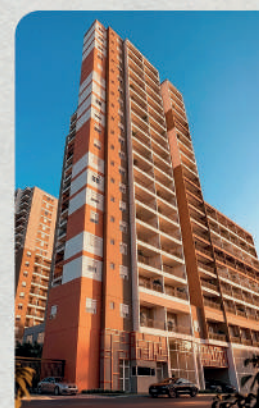
EM OBRAS Supera Conceição A apenas 650 metros da Estação Conceição
