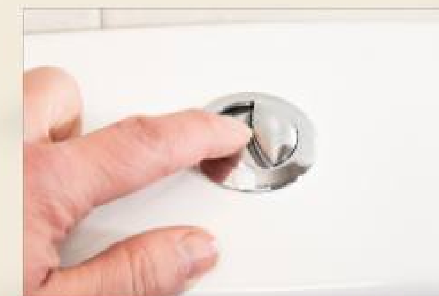
Sistema Dual Flush nos vasos sanitários
